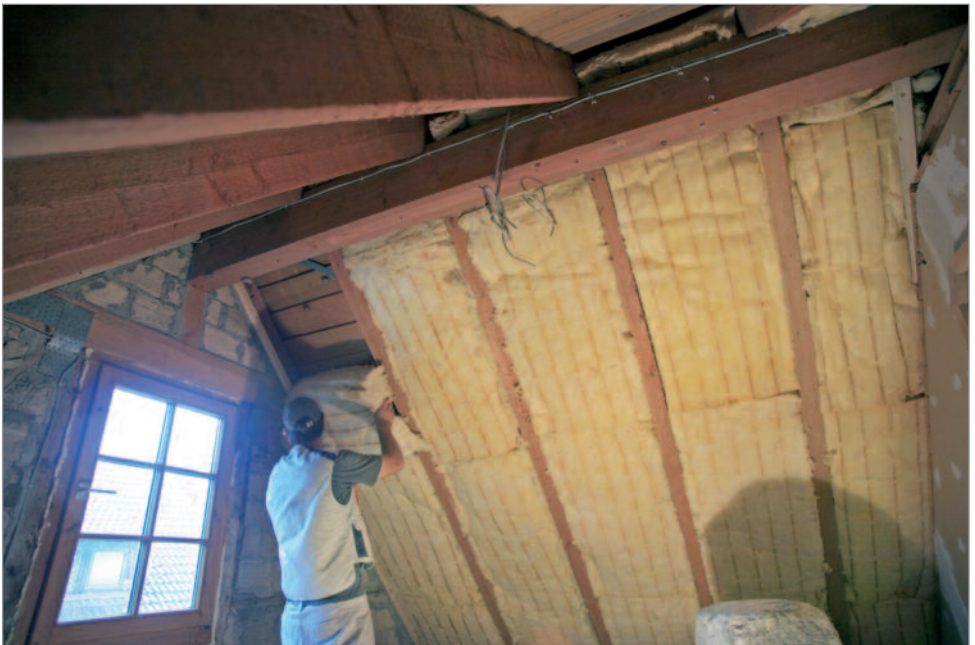
Fachgerechte Dämmung eines Dachraums 11
